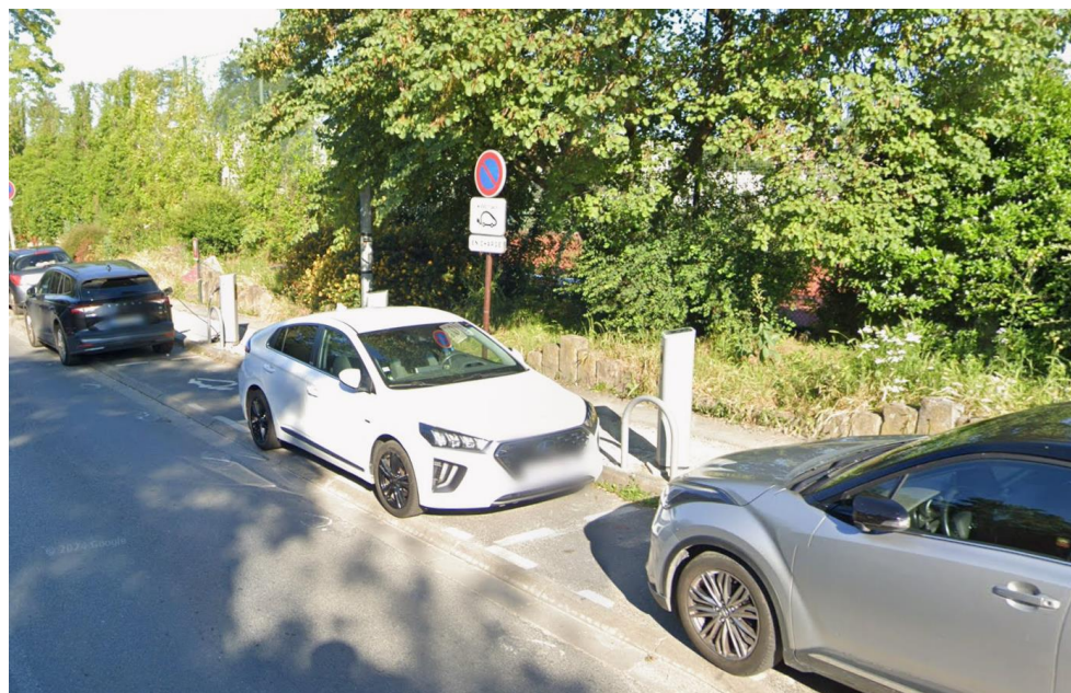
Bornes de recharge électriques le long de la rue Marcel Ethis – Google Street View, juin 2024
