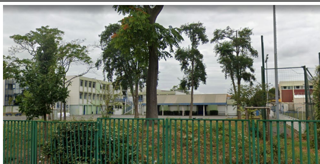
Vue 1 sur le collège G.Courbet et sa cour situé à l'ouest de la parcelle – Source : Google Maps
