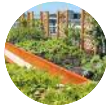
Toiture du programme LAB21 accueillant 1 000m 2 (2020)
