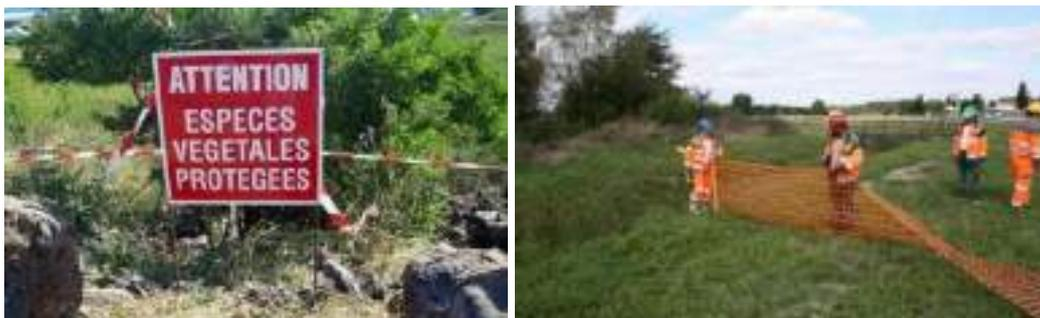
Figure 41 : Exemple de mise en place d'un balisage d'un site sensible vis-à-vis d'un projet d'aménagement © BIOTOPE
