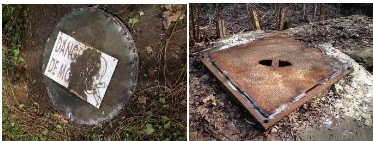
Figure 7 : Puits d'entrée à gauche côté château et à droite côté parc départemental -source Région Ile-de-France
