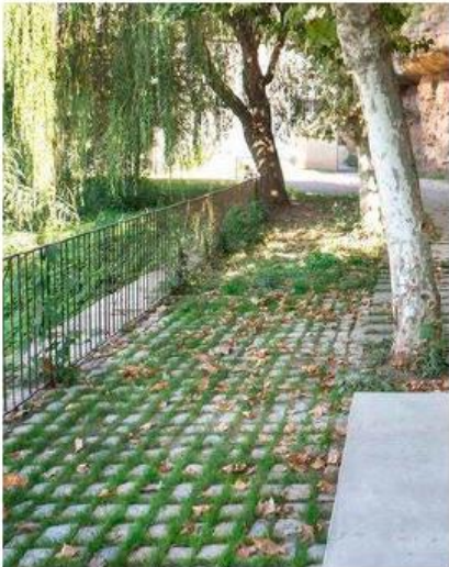
Sols perméables : pavés joints engazonnés
