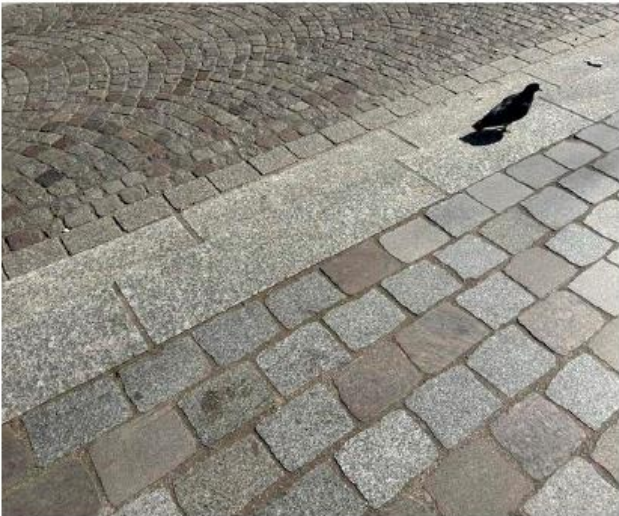
Grès et granit avec joints en mortier gris
