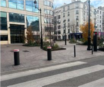
Bornes retractables anti-béliers et contrôles d'accès
