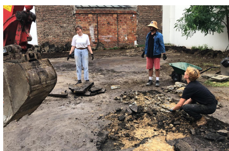
Désimperméabilisation par la machine...
