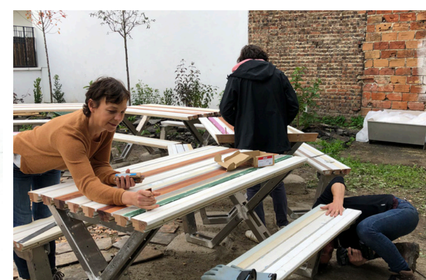
15 octobre – chantier participatif «végétale».
