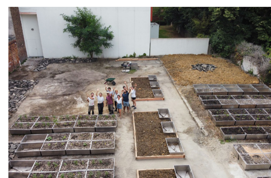
Fin de chantier phase 1 !
