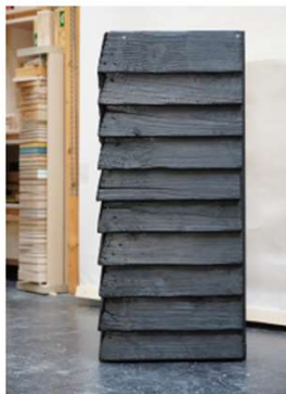
Référence: Prototype d'étudiants de l'école d'architecture de Paris Belleville dans le cadre d'un studio de projet Technique du bois brûlé au four
