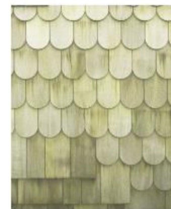
Façade Bardeau de bois en écailles Lasure verte sauge
