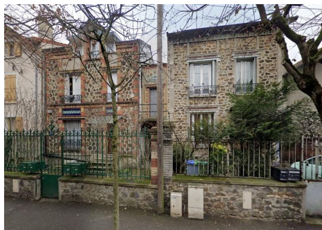
Bondy – 11-11bis rue du Lion Maisons pavillonnaires de niveau 2
