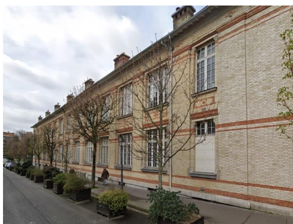
Les Lilas – Ecole Waldeck Rousseau Edifice scolaire de niveau 3
