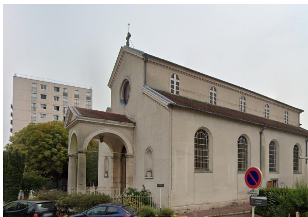
Noisy-le-Sec - Eglise Saint-Etienne Edifice du culte de niveau 1
