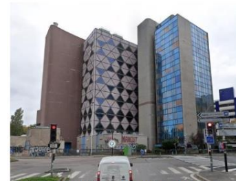
Ancien immeuble France Télécom à Bagnolet
