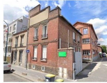
Atelier rue Méhul à Pantin
