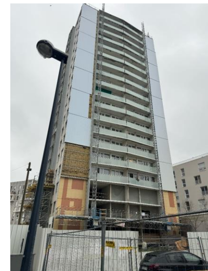
Façade OUEST de la Tour A
