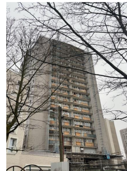
Façade EST de la Tour A
