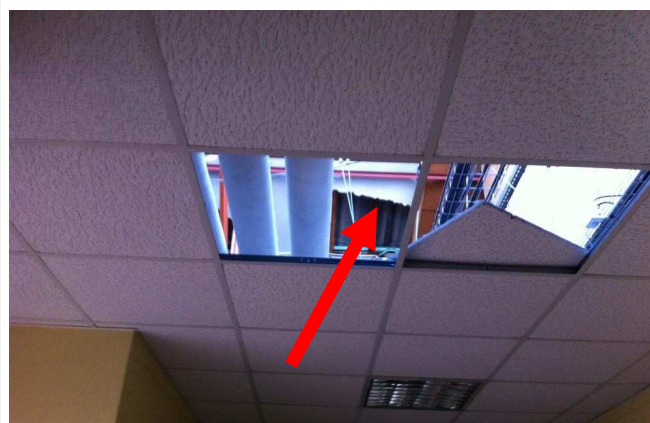
Composant : Plaques ondulées en toiture 11 (a) Plaques ondulées Couverture de la partie bureaux
